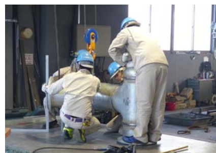
▲加工管組立の様子
