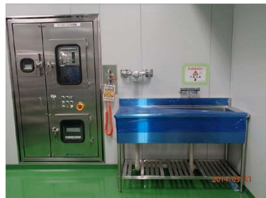
▲現場写真 シンク廻り
