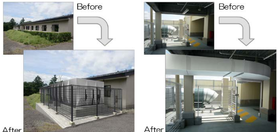
▲消火水槽・ダクト設置イメージ（レタッチ）
