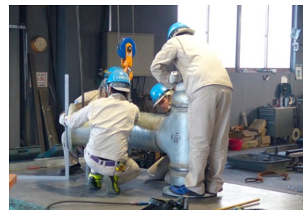
▲加工管組立の様子
