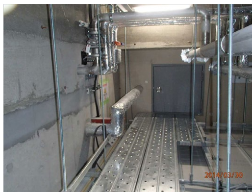
▲現場写真 天井内メンテナンス歩廊
