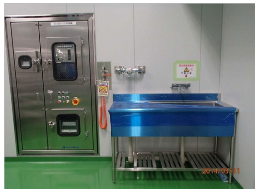
▲現場写真 シンク廻り
