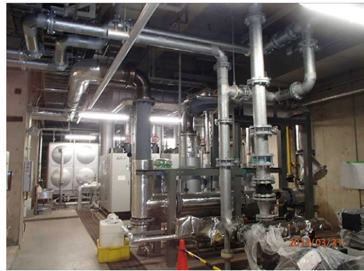
▲現場写真 ボイラ機器廻り
